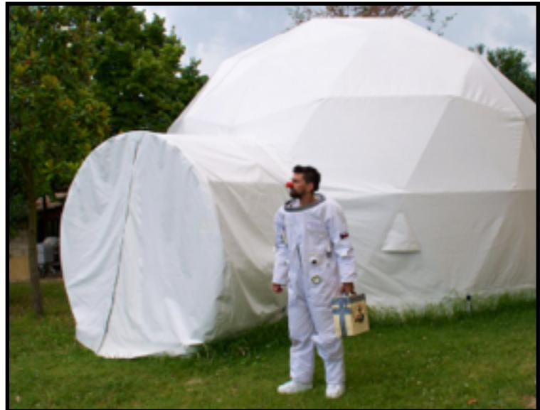
La caratteristica principale di questa originale struttura è di essere **autoportante**, cioè permette di **poterla collocare in qualsiasi sito** senza modificarne in nessun modo la conformazione originale, niente picchetti a terra, nessun peso esterno di ancoraggio.
