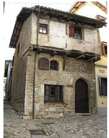
La casa non nasce da un progetto autonomo ma riutilizza una precedente struttura in pietra, molto probabilmente una torre come mettono in luce i corsi regolari di pietra ben squadrate, presenti sulla parete esterna destra della costruzione.
